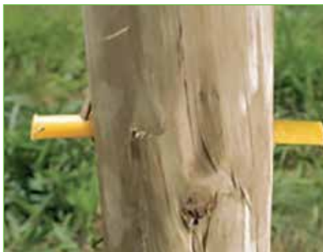
Imagem 9: Isolamento com tudo isolador apropriado.
